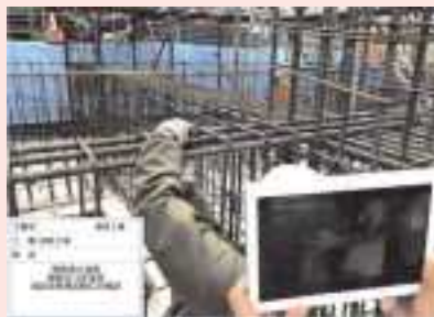
Webカメラを利用した遠隔検査
