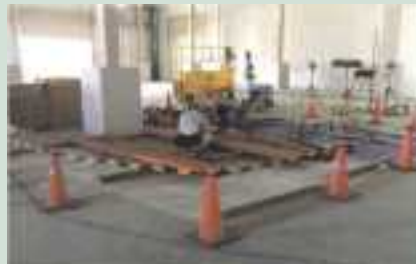
工事エリアの区画を設定して作業
