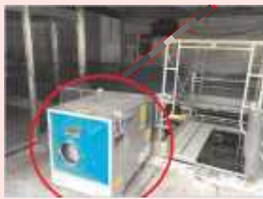
集塵機を設置し室内の換気を実施
