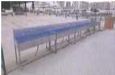
現場の手洗い場所の増設
