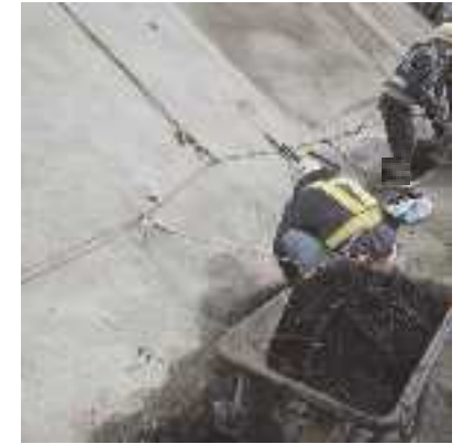
作業時なるべく離隔を確保
